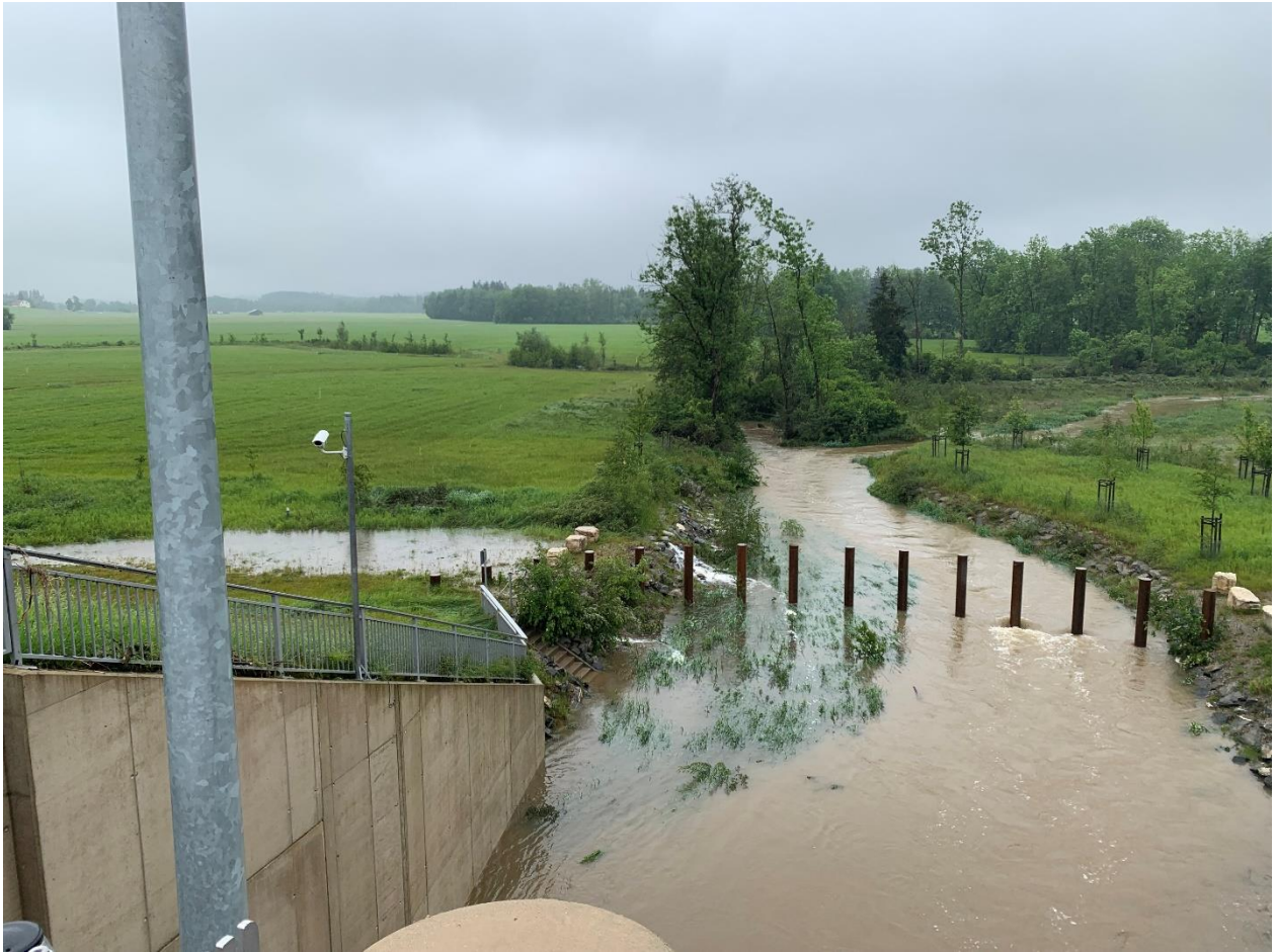
Das Becken in Eldern ist leer. Der Betriebsauslass ist 100% geöffnet und der Durchfluss liegt bei ca. 15 m 3 /s.
