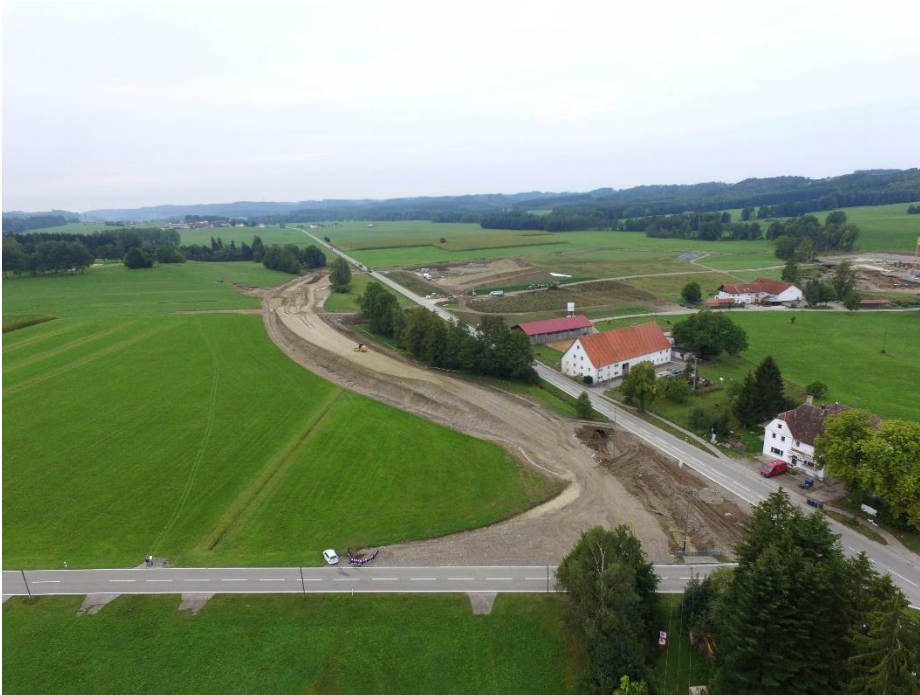
Foto WWA Kempten: Baustelle Straßenverlegung St 2011 vom Sept. 2018
