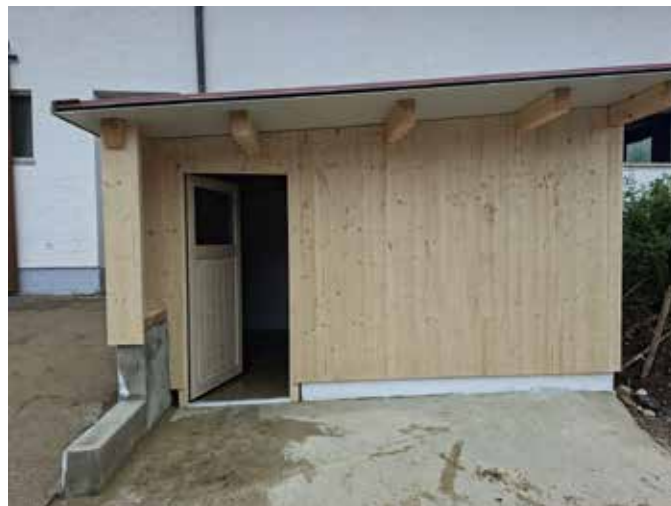
Das neu gebaute Verkaufshäuschen beim Biohof Kirchensteiner, in dem der Automat aufgestellt wird.
