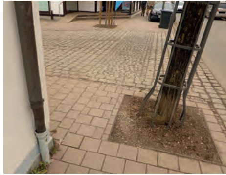
Abb. 85: Beispiel verengter Gehweg durch Bepflanzung in der Bahnhofstraße
