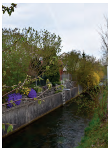
Abb. 61: Zugang Westliche Günst
